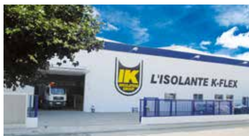
L'ISOLANTE K-FLEX ESPAÑA, S.A. Oficinas y almacén, Barcelona
