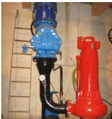
VÁLVULA DE RETENCIÓN A CLAPETA CON CONTRAPESO
