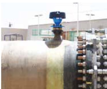
VÁLVULA DE AIREACIÓN TRIFUNCIONAL
