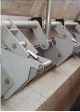
**Las compuertas oscilantes de aliviadero de TALIS** se utilizan para controlar el nivel, para la descarga y para el lodo en flotación en las plantas depuradoras de aguas residuales. Se instalan en compartimentos estructurales y permiten una gran descarga en anchura con poco recorrido en altura.
