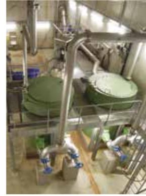
**Las estaciones de bombeo de aguas residuales AWALIFT** son unidades de bombeo de aguas residuales de funcionamiento automático de una o más bombas. La combinación exclusiva de bomba centrífuga y separador ofrece una fiabilidad extrema del sistema con una protección óptima de las bombas contra las obstrucciones. Las unidades AWALIFT son sistemas cerrados con bajos costes de mantenimiento y sin molestias producidas por los olores. Aptas para aplicaciones de alta presión.
